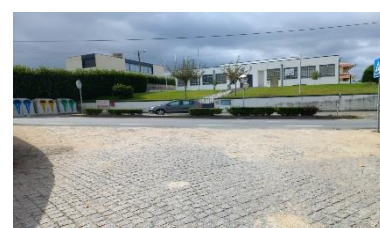
Reparação pavimento Rua da Veiga (Parada de Tibães)
