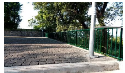
Colocação de grade no recinto da Capela S. Sebastião (Parada de Tibães)
