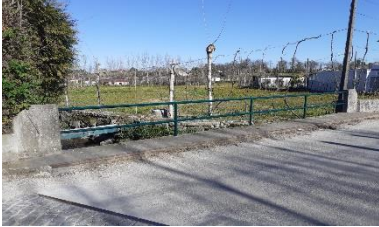
Pintura das grades das pontes sobre a Ribeira de Panóias (Panóias)
