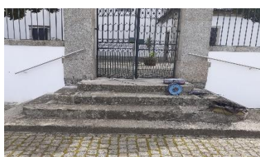
Colocação corrimão nas escadas do cemitério (Merelim S. Paio)
