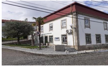
Limpeza/Lavagem pavimento exterior – Sede Junta Freguesia (Merelim S. Paio)
